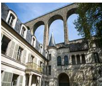
conservatoire à rayonnement départemental
